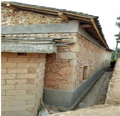
配筋砂浆带加固
