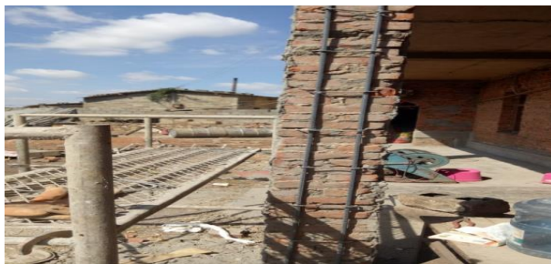
支撑柱加固方式
