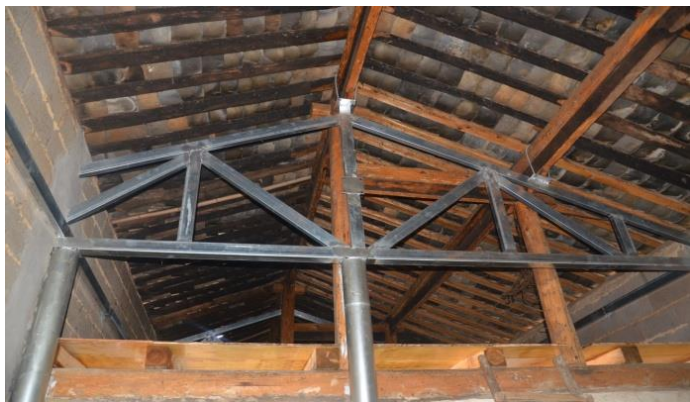
纵横桁架结构加固、节点加固
