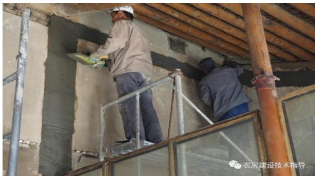
加固施工过程
