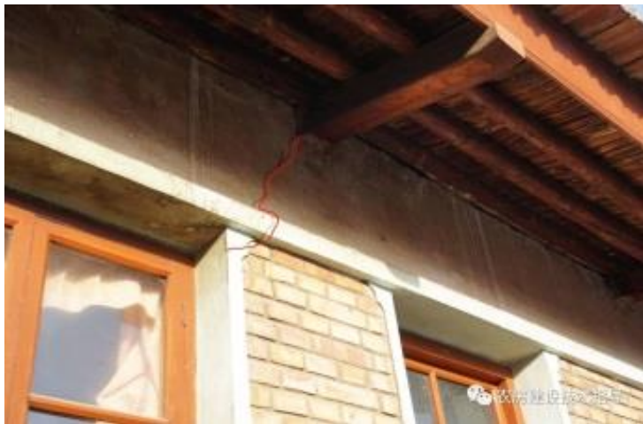
砖墙裂缝
