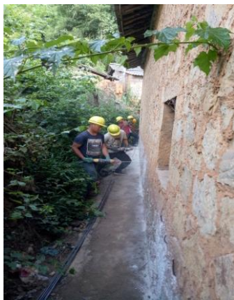
配筋砂浆带钢筋安装
