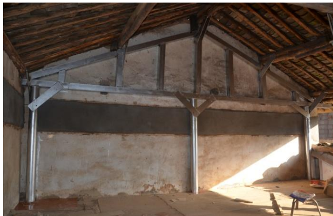
山间墙钢架加固
