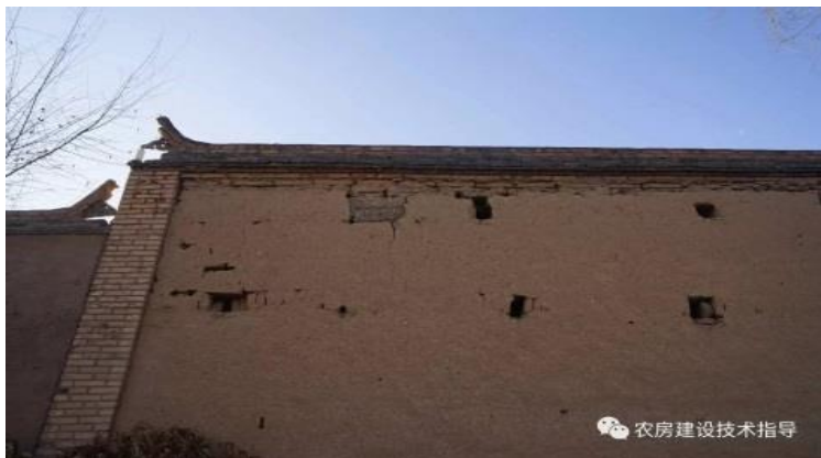
土坯墙裂缝
