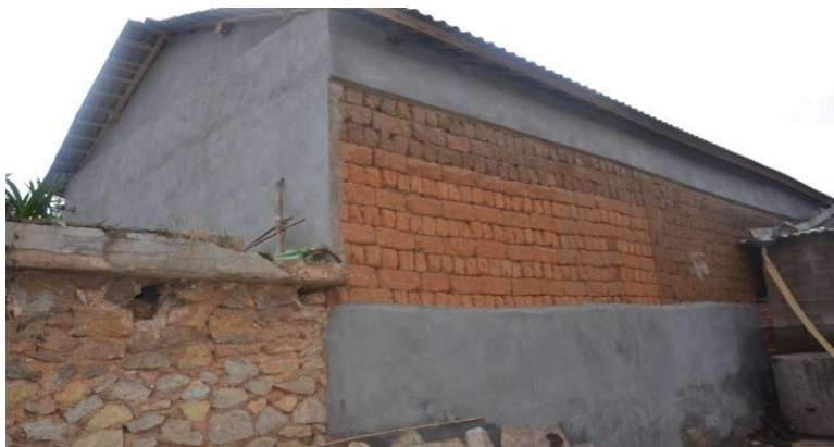
墙体配筋砂浆带加固
