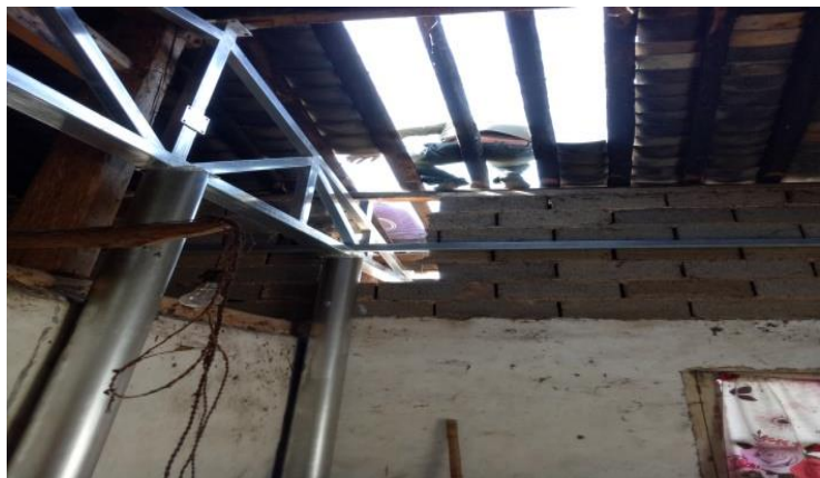
支撑柱、屋面加固施工
