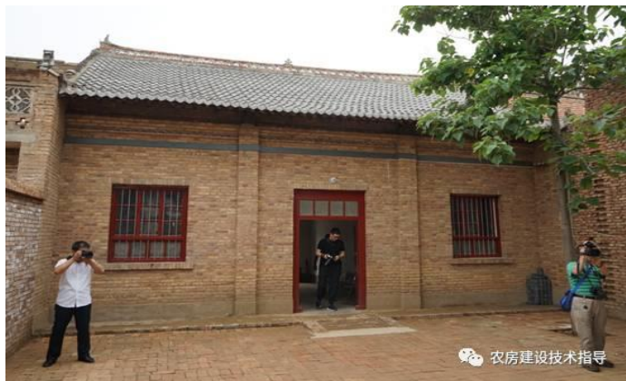
房屋加固维修完成
