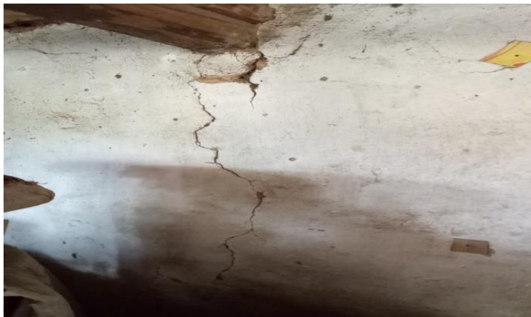
墙体倾斜局部
