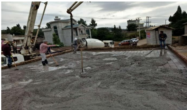
现浇混凝土楼板
