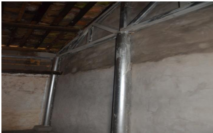
山间墙钢架加固
