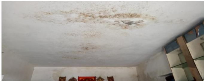
板面贯通断裂
