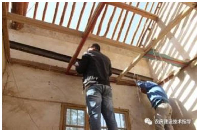
房屋加固维修施工过程
