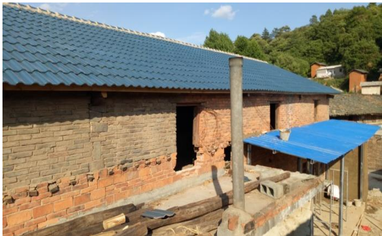
屋面木梁、瓦片更换
