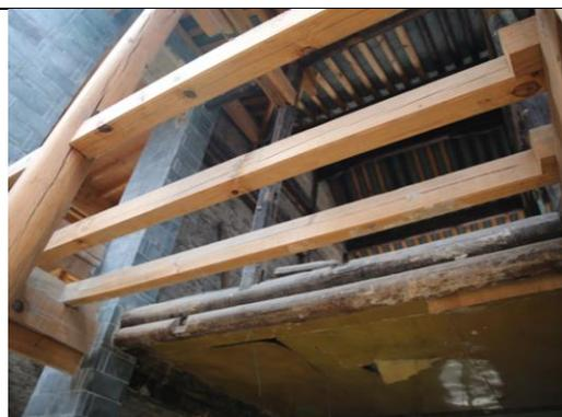
对历史建筑结构进行修缮加固，提高建筑抗震能力
