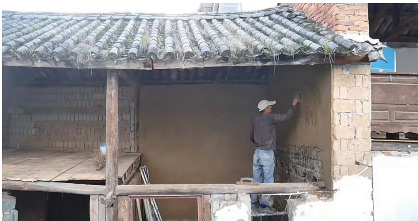
填补修整墙地面缝隙及面层破损
