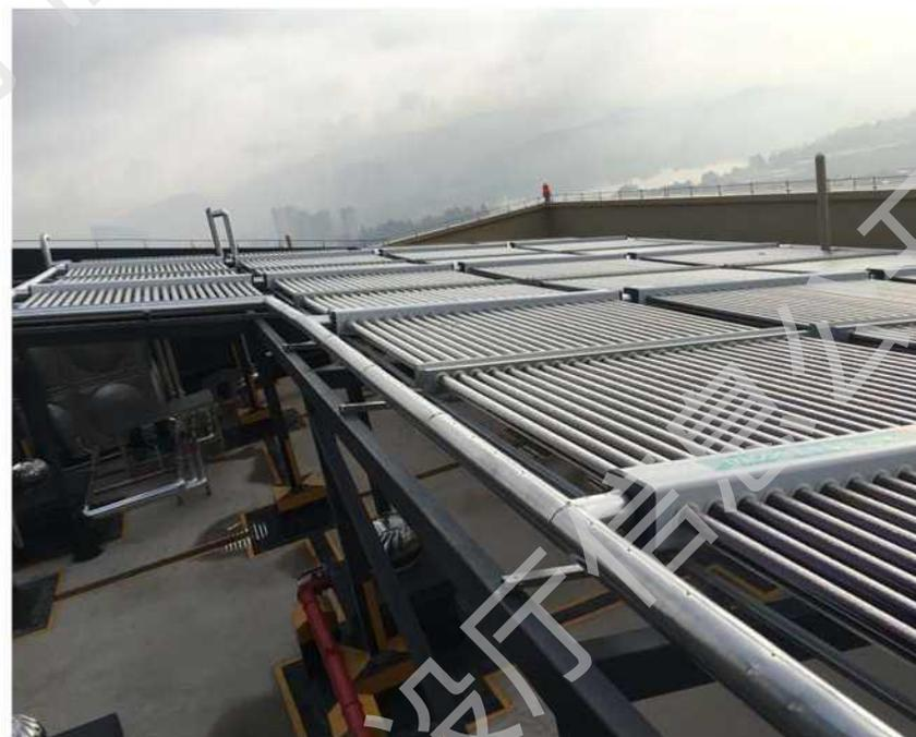
【项目概况】昆明万科公园里项目共9栋高层住宅楼，给水系统分为市政直供区和变频加压高低区，热水系统供水高区顶部11层采用集中太阳能辅助空气源热泵供应热水。设置真空管型太阳能集热器，总集热面积1209.6m<sup>2</sup>，设计总用水量72 m<sup>3</sup>/d。
