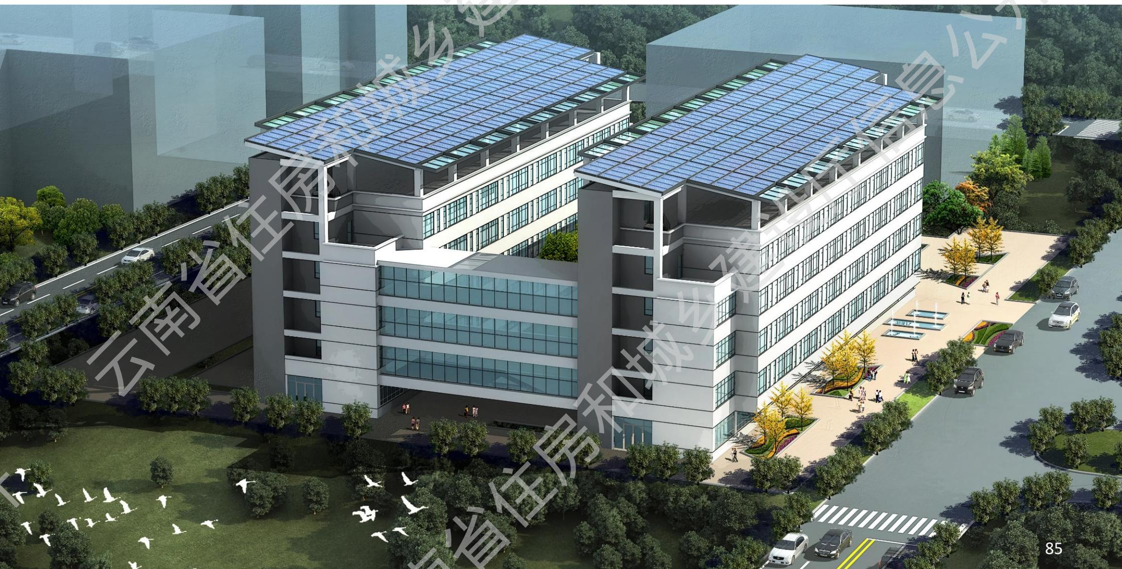
现代建筑太阳能一体化设计效果图 2 ——太阳能光伏系统
