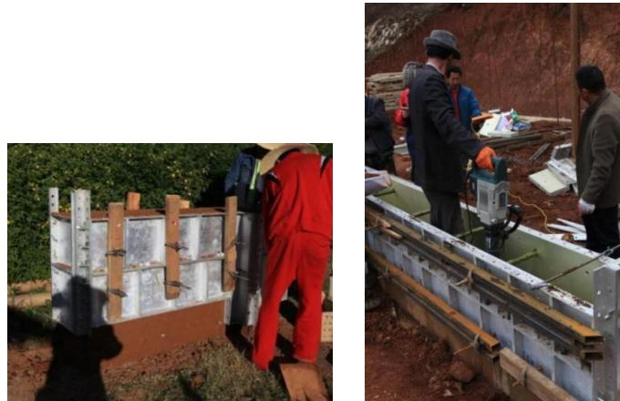
图 8-23 架设模板示意图
