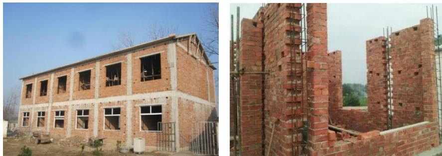
图 6-3 砖混结构农房构造示意
