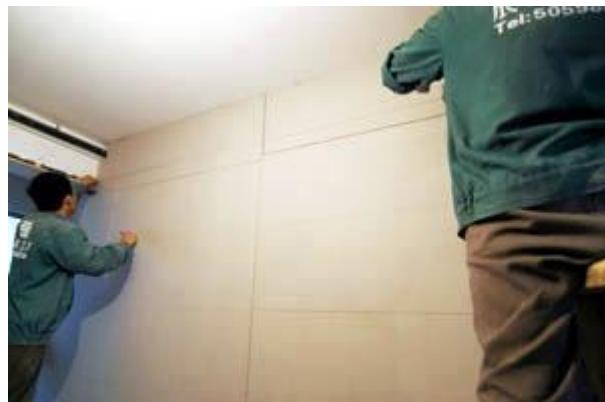
图 7-49 弹顶棚标高水平线
