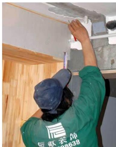
图 7-48 量出顶棚设计标高
