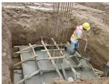
图 7-19 混凝土浇筑
