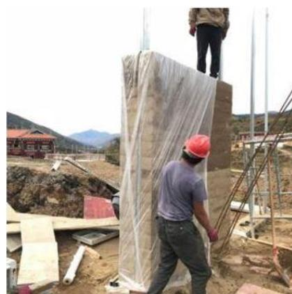
图 8-19 正确墙体覆盖图
