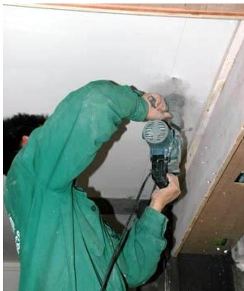
图 7-50 冲击钻打眼埋管螺栓图
