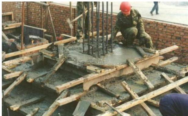
图 7-20 混凝土找平
