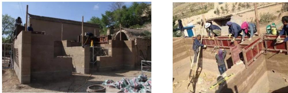
图 6-7 生土墙内木构造柱的设置
