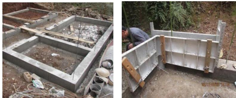
图 8-25 模板夹住地梁圈
