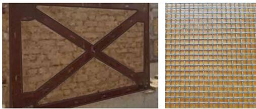
▲ 如图所示,可考虑在墙内侧进行加固,不影响外部风貌。
