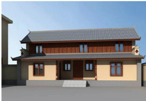
建筑平面布局主要包括一字型、曲尺型（L型）、门字型（三合院）等建筑形式。木构架用穿斗式、抬梁式混合使用，利于抗震。外墙多用夯土墙或土坯砖。一般有石勒脚、石柱础。
