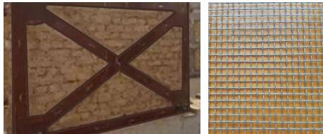
▲ 如图所示，宜考虑在墙内侧进行加固，不影响外部风貌。
