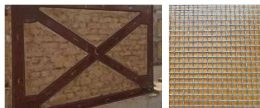
如图所示，可考虑在墙内侧进行加固，不影响外部风貌。
